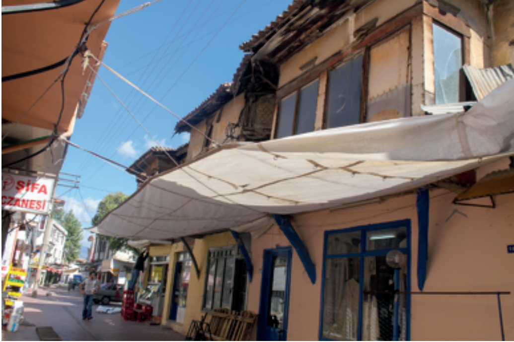
Şekil 15: Güneydeki yapının cephe özellikleri.
