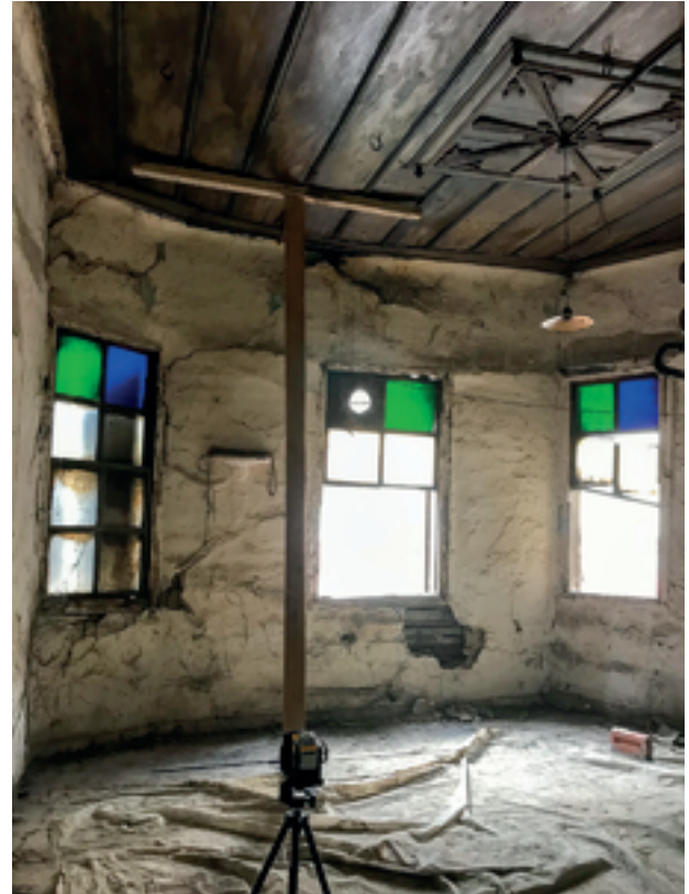
Şekil 5: A bölümünde caddeye bakan odanın iç mekanı, Tümerdirim Evi, Balıkesir.
