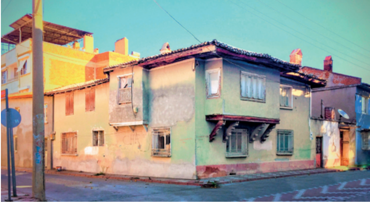
Şekil 1: Kökden evi dış görünüşü.
