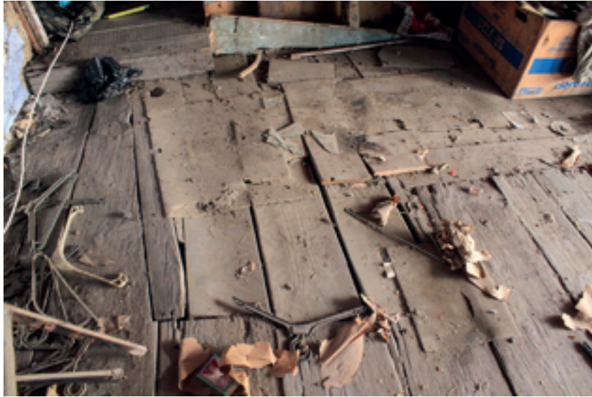
Şekil 8: Döşeme üzerinde, kapatılmış özgün merdivenin yeri.
