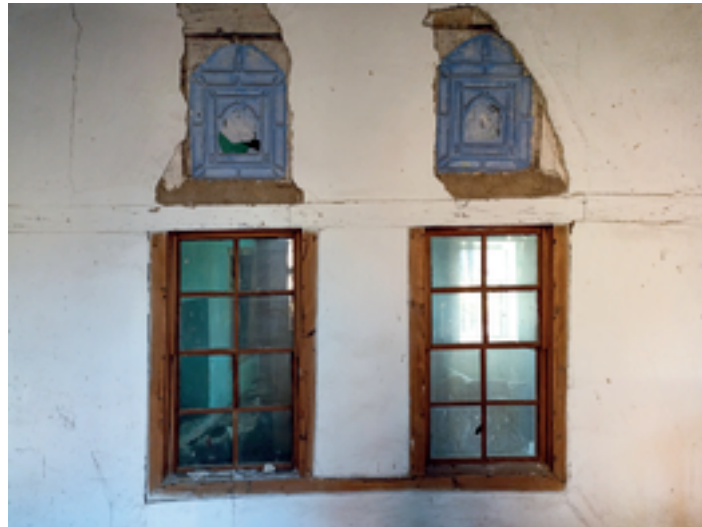
Şekil 5: 102 no'lu Oda'nın Hayat'a açılan duvarında tepe penceresi izleri.
