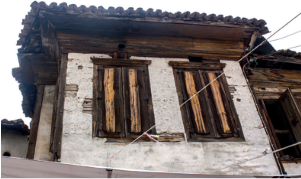
Şekil 13: Saçak silmelerinin altında tepe pencerelerine ait izler.
