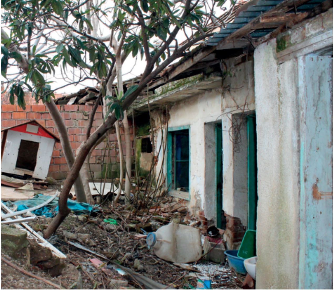
Şekil 11: Arka bahçe ve müştemilat cephesi.
