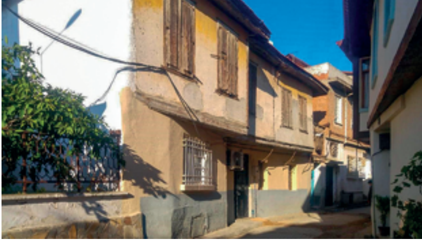
Şekil 1a: Konutun yol cephesi.
