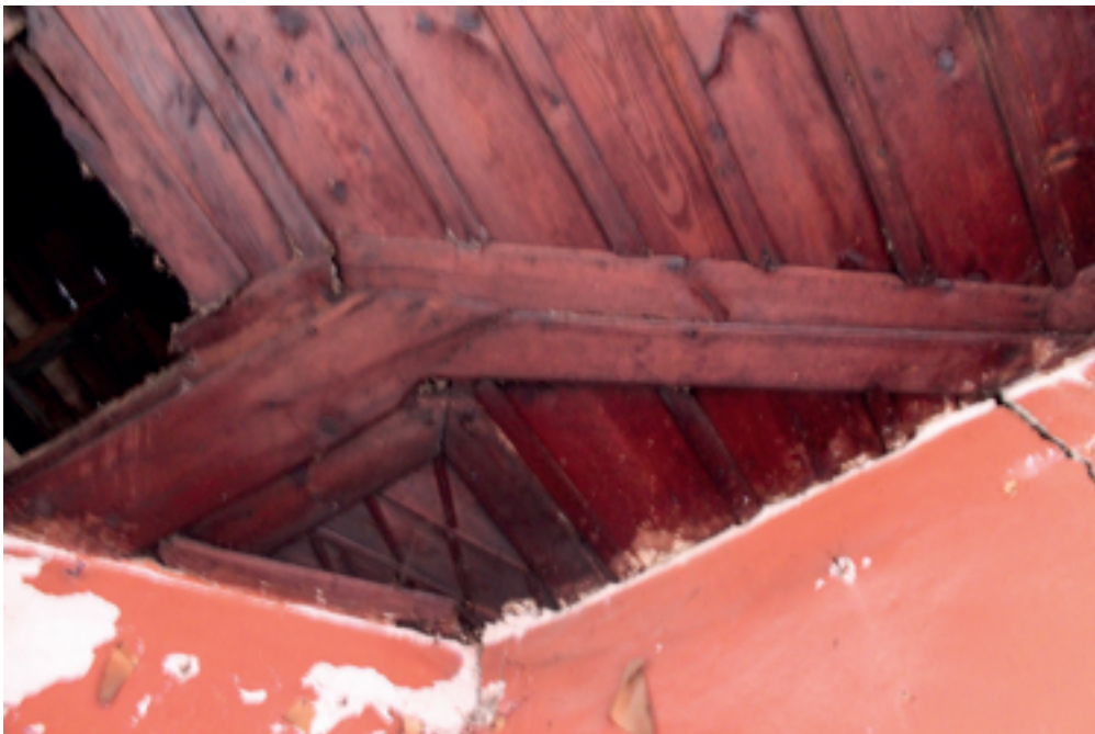
Şekil 11: Tavanda odanın eski sınırlarını gösteren izler.
