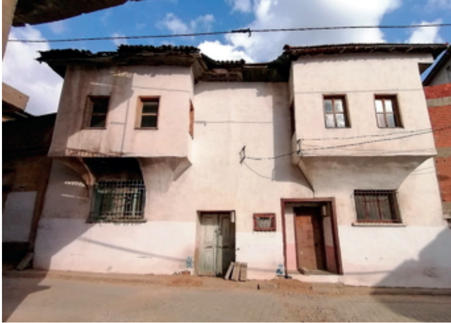
Şekil 1: Güneybatı (232. Sokak) cephesinden görünüm (22-21. parsel).
