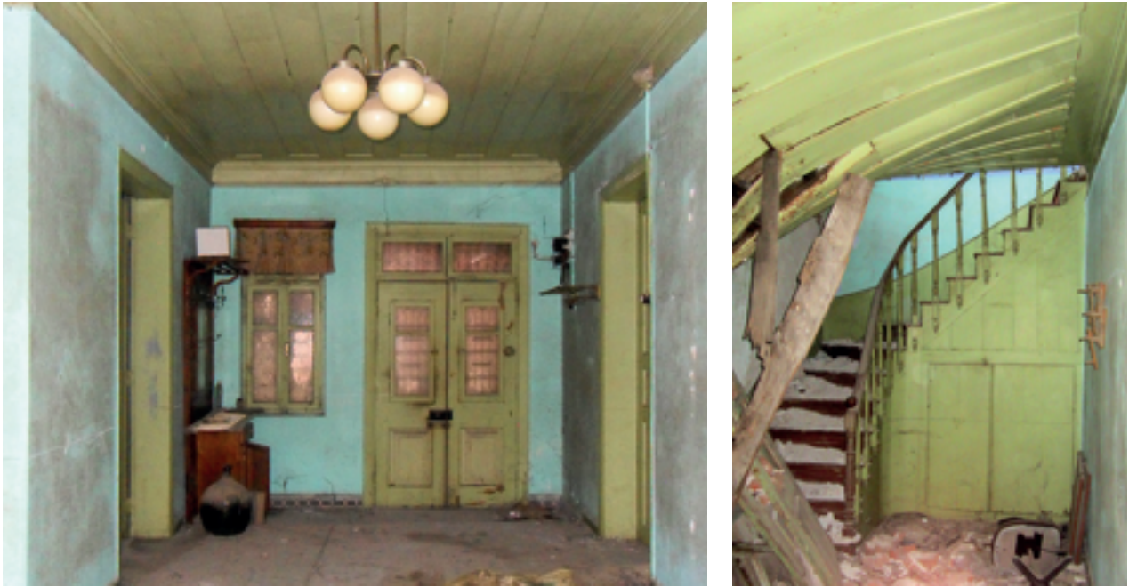
Şekil 6-7: Zemin kat sofasından görünümeler.
