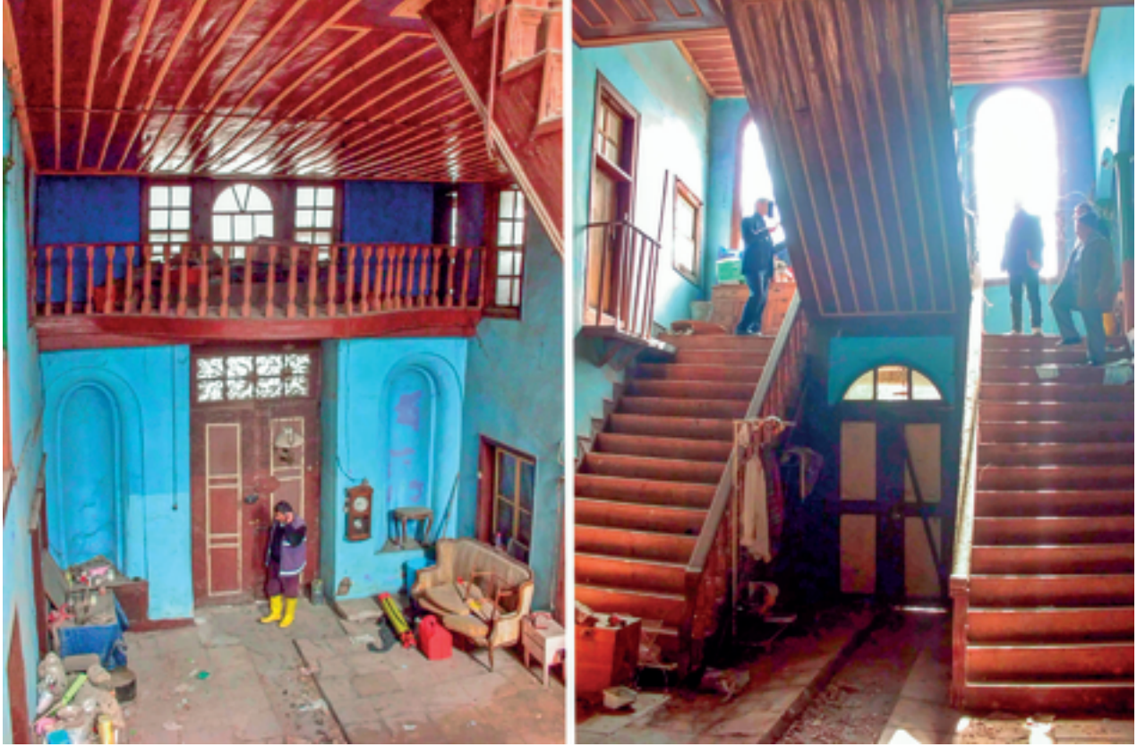
Şekil 4: Zemin kat ve ara kat taşlık mekânı.
