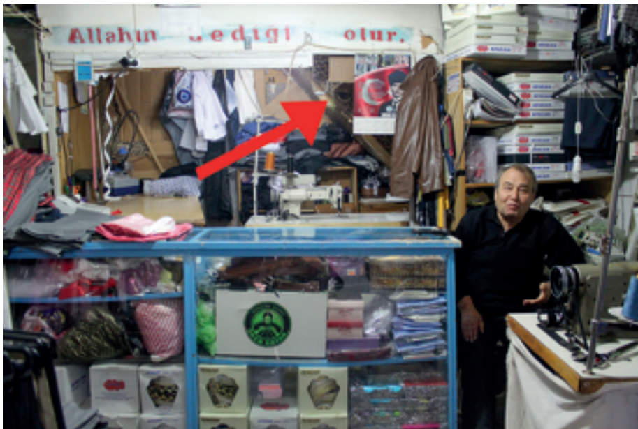
Şekil 18: İkinci dönemde eklenen iki kollu ahşap merdivenin altı (Merdivenin girişi, oturan kişinin arkasındaki dolap ile kapatılmıştır)
