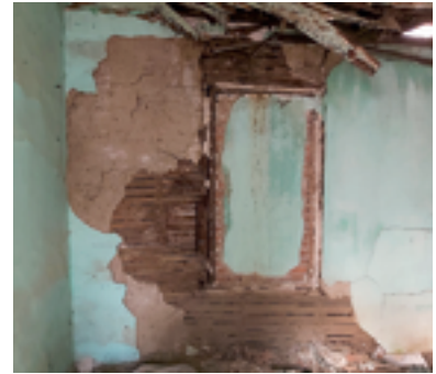
Şekil 9: Kapatılmış pencere izi.
