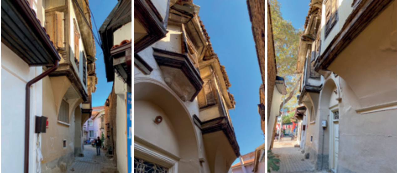
Şekil 1-2-3: Güneydoğu cephesi (163. Sokak) görünümü.
