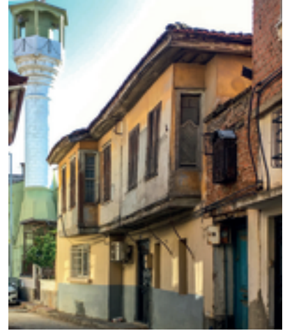
Şekil 1b: Konutun 225. Sokaktan görünümü.
