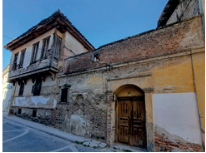
Şekil 2: Bina 1 Bahçe duvarı görünüşü, 2013.
